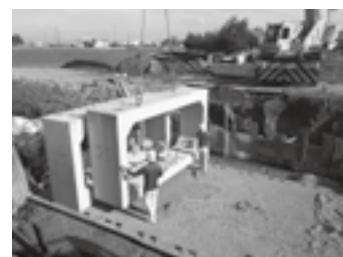
大型ボックスカルバート据付▶P.7
