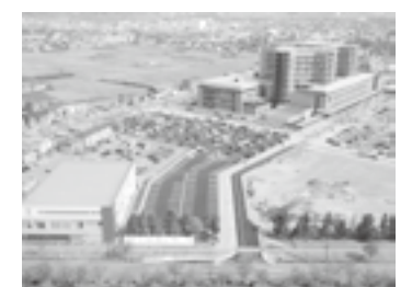
石川県立中央病院 （外構・造成工）▶P.23
