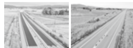
R2日東道交通安全施設整備工事 新潟県村上市南新保～村上市牧目
