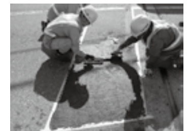
施工状況▶P.85
