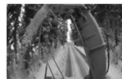
IoTセンサーを活用した 建設機械稼働状況管理 ▶P.25
