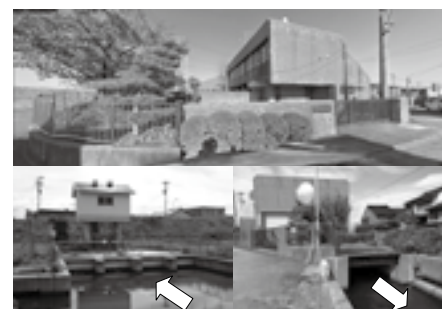
施設の外観(上)、取水口(左)、吐き出し口(右) ▶P.5
