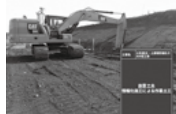
作業土工施工状況 ▶P.7
