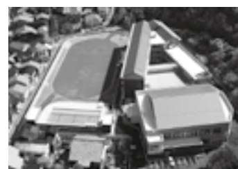
佐渡市 相川小学校校舎・ 体育館・プール建設工事 ▶P.21
