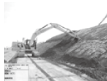
ICT建機による法面切土状況▶P.21
