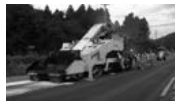
MAP工法を用いた舗設状況▶P.13
