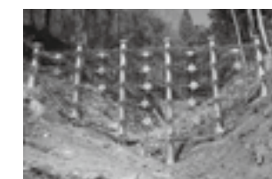
【施工完了写真②】
