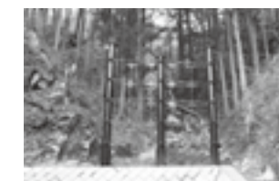
【施工完了写真①】
