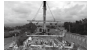
コンクリート橋の床版取替状況 ▶P.29
