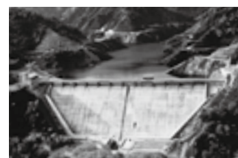
正善寺川ダム建設工事▶P.25
