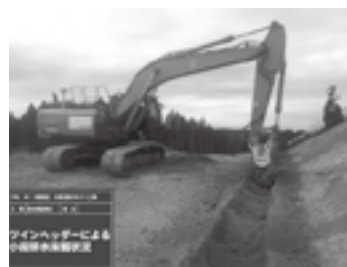
小段排水の掘削状況▶P.17
