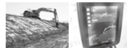
MCバックホウによるICT施工▶P.91
