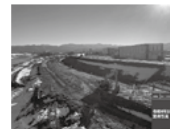
工事着手より2ヶ月経過後 日本海建興(株) 土木舗装部 吉田 周平 さん▶P.100
