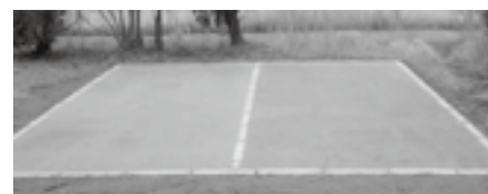
施工場所（3か月後）
