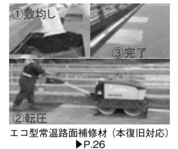
エコ型常温路面補修材（本復旧対応）▶P.26
