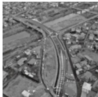
完成後の状況▶P.7
