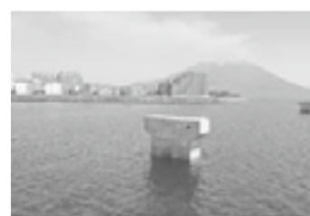
橋脚P 6下部工完成写真▶P.19
