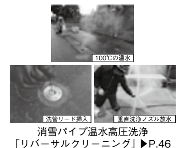
100℃の温水 洗管リード挿入 垂直洗浄ノズル放水 消雪パイプ温水高圧洗浄「リバーサルクリーニング」▶P.46
