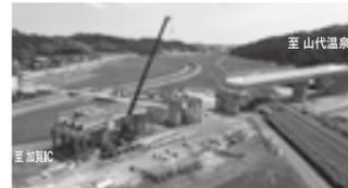
アプローチ部の架設(TC架設工法)
